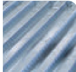
Lamiera grecata elemento strutturale a supporto del calpestio Corrugated steel structural element supporting the planking level
